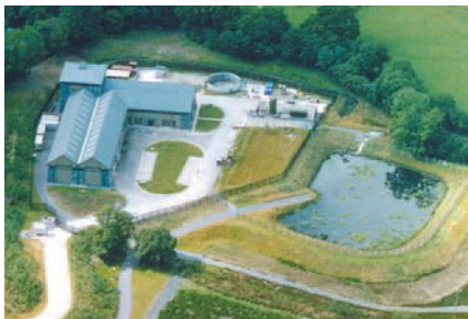
Beispiel für eine schwer erreichbare Pumpstation.
