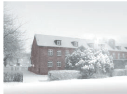
Geschlossene Schulen und kaltes Wetter sind kein Problem für eine ALPHA-Steuerung
